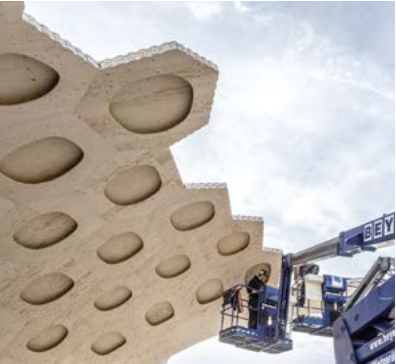
→ Ontot kasettisegmentit koottiin osittain etukäteen ja liitettiin paikan päältä yhteen ilman alarakenteita tai tukitelineitä.
